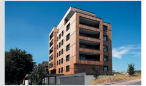
Eine Pionierleistung: 6-stöckiger Holzbau.
