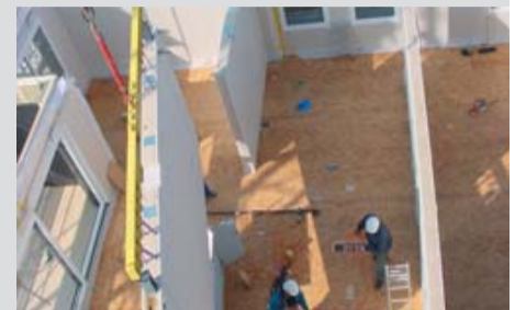
Das Plattenmaterial wurde auf Mass geschnitten und stockwerkgerecht palettiert.
