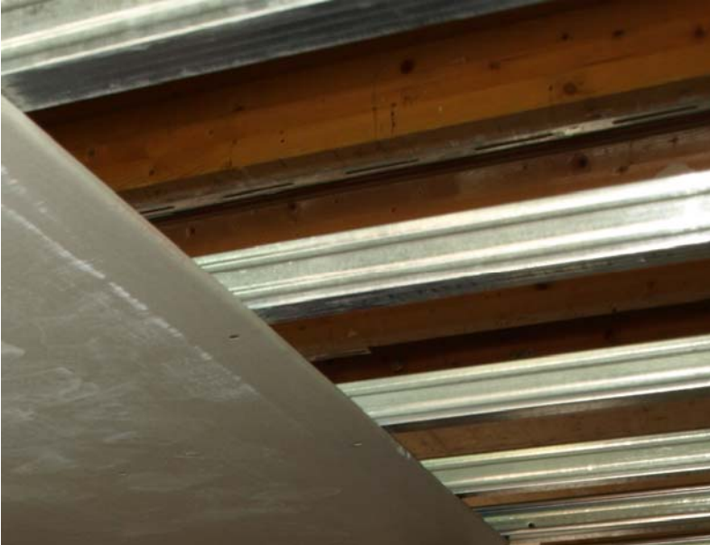
Freitragende Decke mit Bekleidung Ansicht von unten
