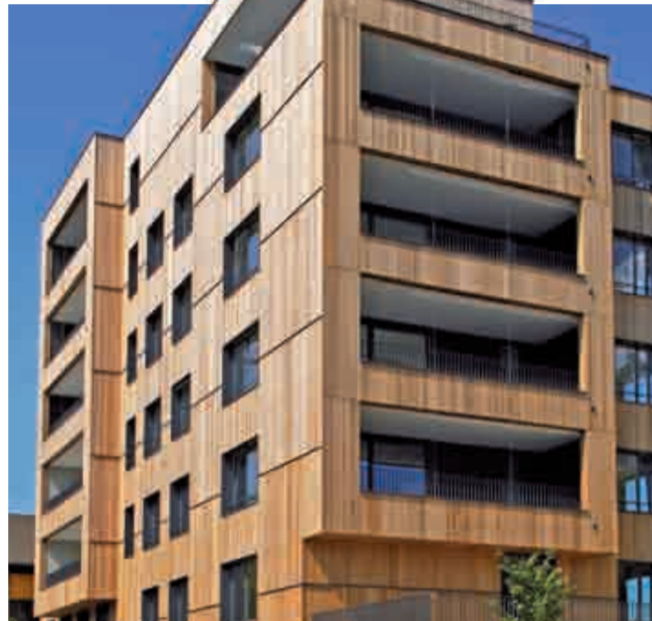
Eine Premiere ist immer etwas Besonderes. So auch das erste 6-stöckige Holzhaus der Schweiz. Das 20 m hohe Mehrfamilienhaus steht in Steinhausen/ZG und ist ein reiner Holzelementbau. Dank neuer Brandschutznormen – und dank Gipsfaser- und Gipsplatten von Rigips.
