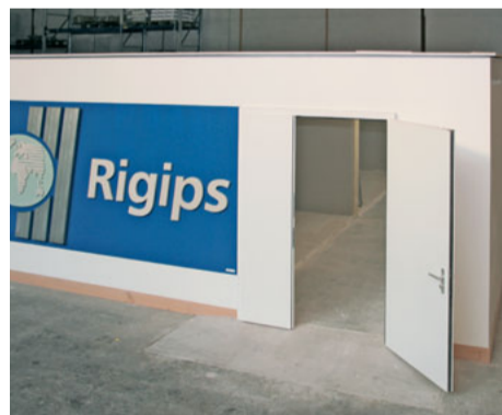
Blick in den neuen Schulungsraum in Lucens.
