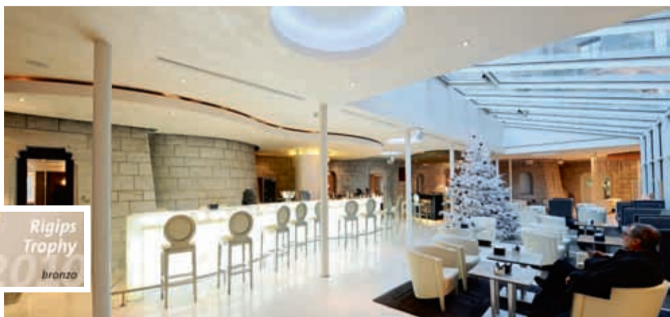
La ristrutturazione del castello di Ouchy a Losanna, realizzata con un controsoffitto acustico in gesso curvato, crea un ambiente moderno in perfetta armonia con il contesto storico. (Foto: Rainer Sohlbank)
