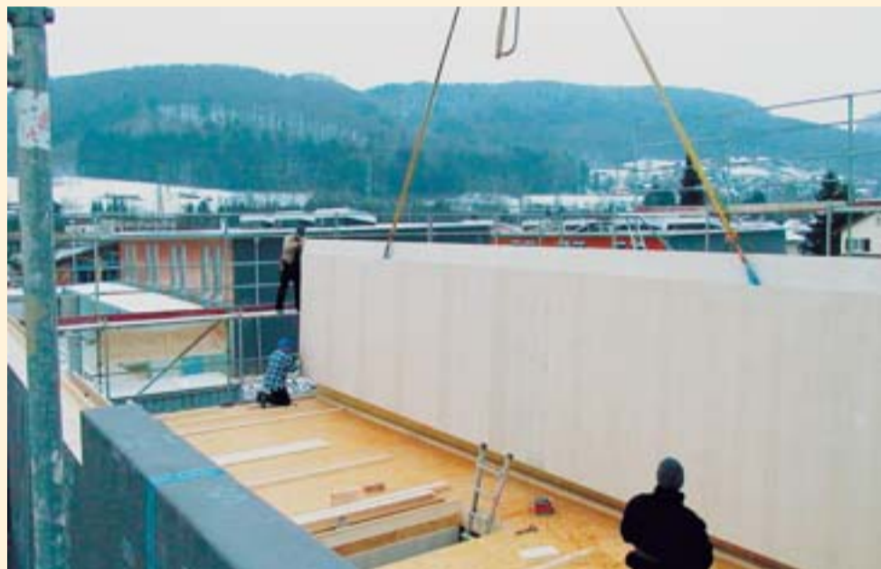
Rigidur unterstützt durch seine Verarbeitungseigenschaften die Rahmenbauweise mit Vorfabrikation.
