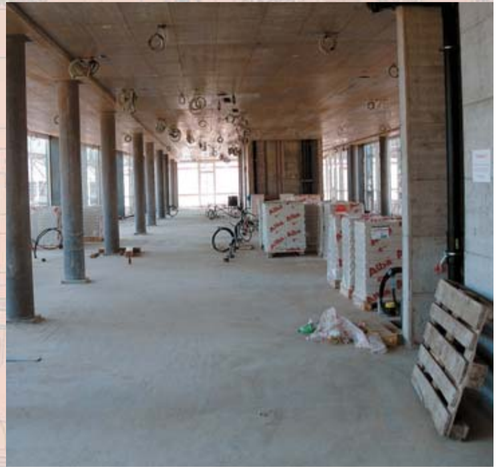
Ein typischer Fall für Alba: Grosse Spannweiten, wenig tragende Elemente.
