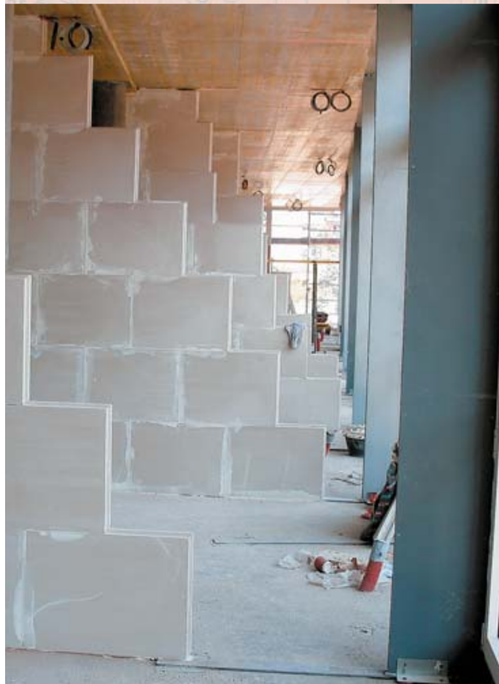
Alba Vollgipsplatten sind schnell und einfach zu montieren.
