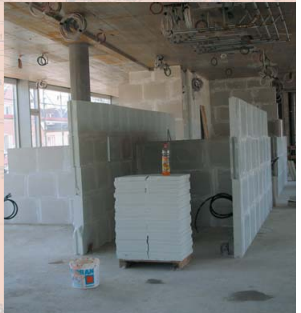
Ein typischer Fall für Alba: Grosse Spannweiten, wenig tragende Elemente.
